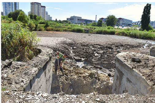
**\*\*\*Чистят и дно. Ил извлекают вручную и с помощью небольших экскаваторов, его складировать на берегу, сушат, а затем будут использовать в качестве плодородного**
