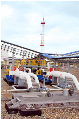
**\*\*\* Новый ПСП оснащен инновационным оборудованием, позволяющим в автоматическом режиме измерять и тоннаж поступающей нефти, и ее качество. Также на новом приемо-сдаточном пункте усилены меры безопасности, построены резервуары аварийного сброса.**
