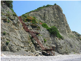
На популярный пляж ведет опасная лестница...
