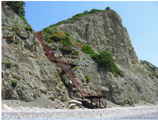
На популярный пляж ведет опасная лестница...
