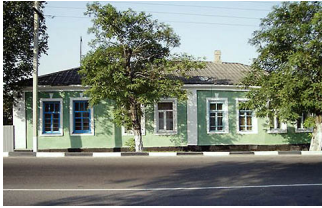
*** Мефодиевка, современный вид чешского дома. Фото автора. 2008 год, ул. Мефодиевская, д. 48.
